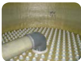
Plancher crépiné inférieur
